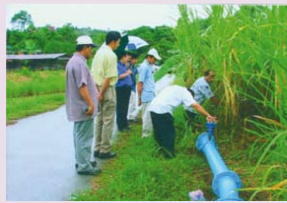
Pemeriksaan akhir ke atas sambungan paip utama ke Jalan Air Panas/Sibulung, Paku, Bau
