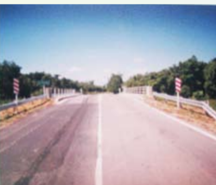
Jambatan Sungai Sebangat
